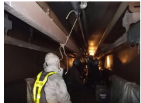
正電車線取替工事（軌道内）
